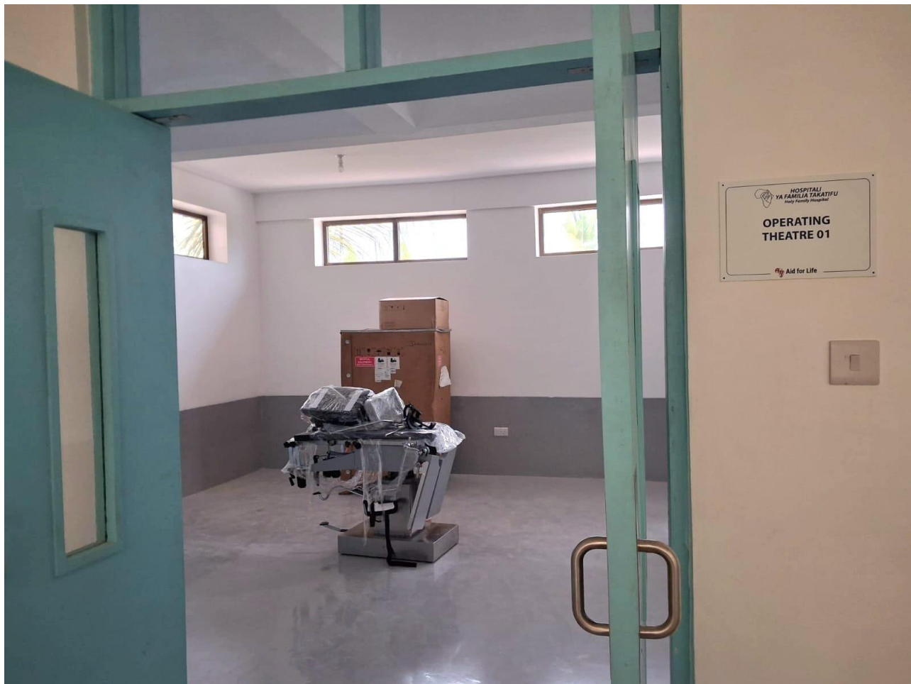
Foto: stato di avanzamento lavori – Mapinga, Tanzania.
