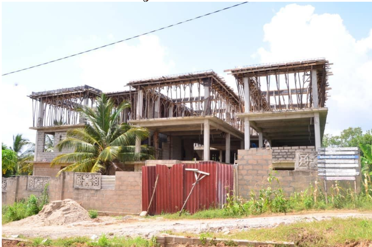
Foto: stato di avanzamento lavori di fine 2023 – Mapinga, Tanzania.
